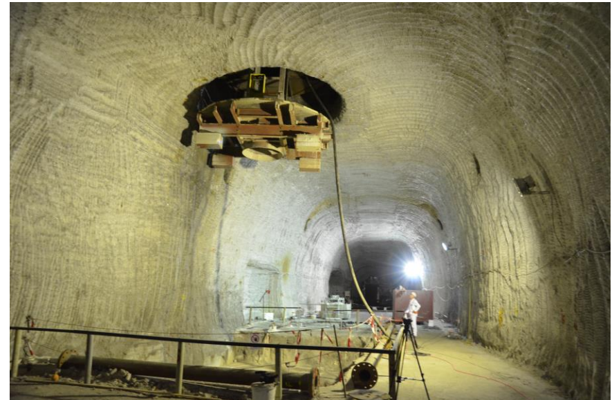
Einkürzen der Baustoffleitung auf der 850-m-Sohle
